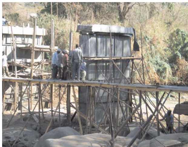
Iderikt: "Bygg en bro när floden sinar!" Bropelare gjuts på den nu torra flodbotten
